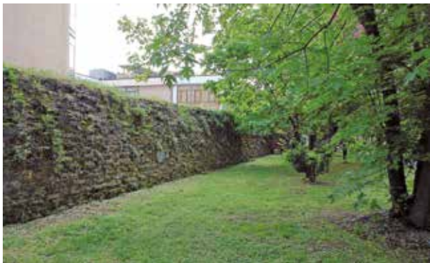
↳ Mura all'altezza della casa albergo di via Zurla.
