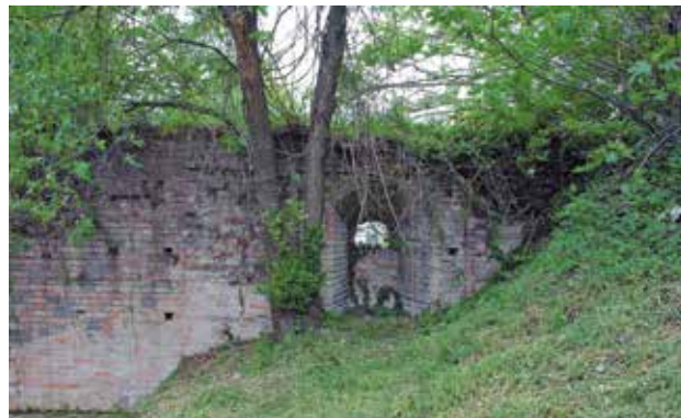
↳ Passaggi voltati presso la casa albergo.
