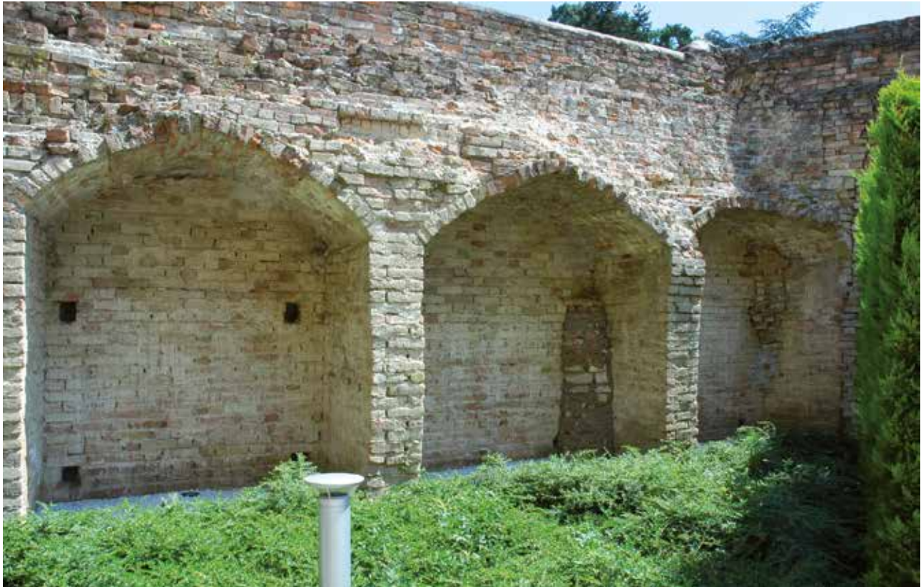
└ Elementi costruttivi addossati alle mura.
