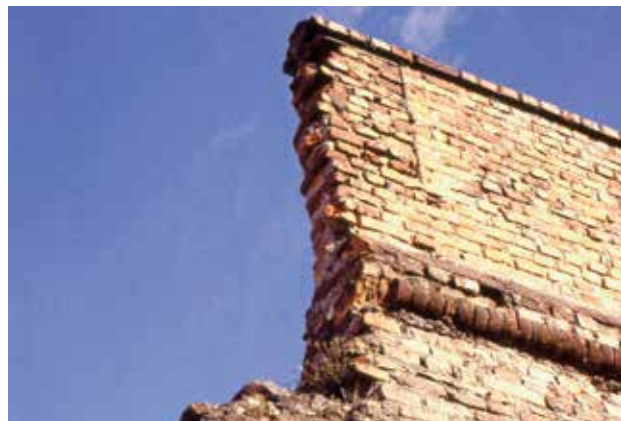
↳ Sopralzo, spalto seicentesco via Pesadori.
