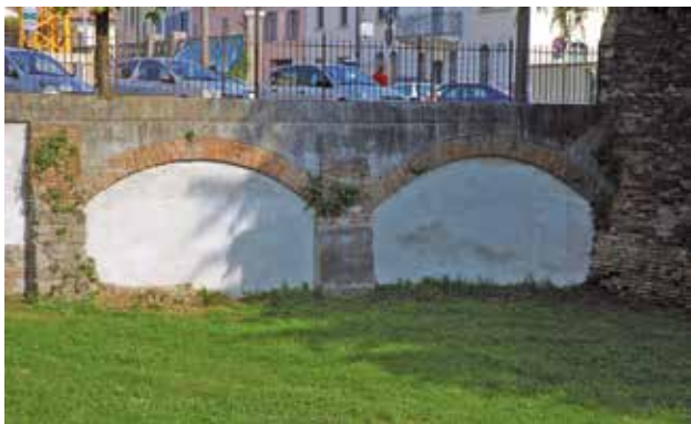
↳ Campo di Marte il fossato delle mura ormai tamponato.
